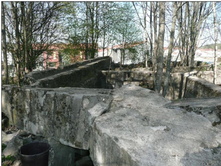
Betonirakenne, bunkkerin tms. jäänn.
